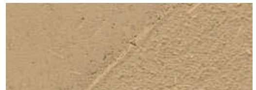
Lehmunterputz trocken, geglättet / gefilzt
